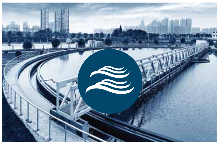
TRATAMIENTO DE AGUA
